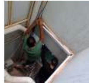
Imagen11. Acomodo de cables y cierre de canaletas.
